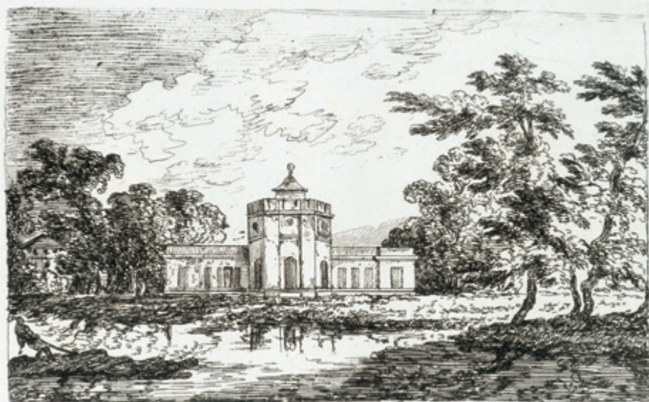
Vue de la Maison de Stomma
