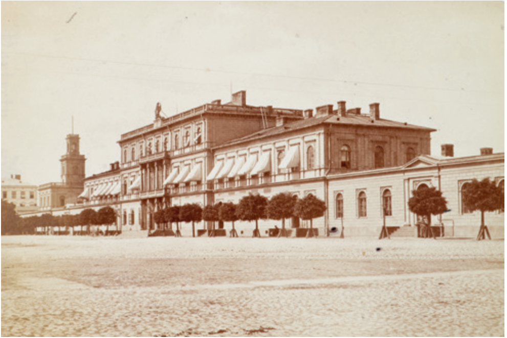
272. J. Mieczkowski. Stacja Główna Drogi Żelaznej w Warszawie. Lata 70. XIX w.
