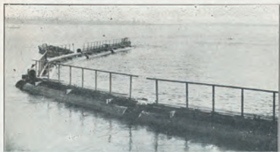
Refuler pogłębnika w skali zwiększonej.
